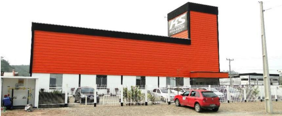
Fachada da fábrica (set/2019).
